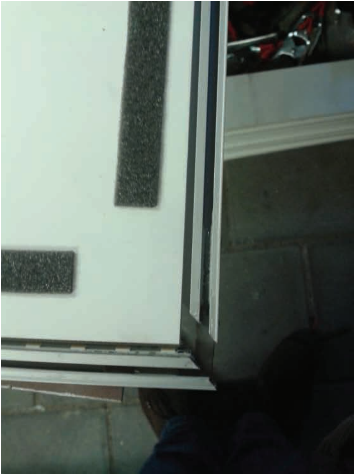
1. De hoek is los: de epoxylijm houdt niet. Het bovenste hoekstuk is ook los.
