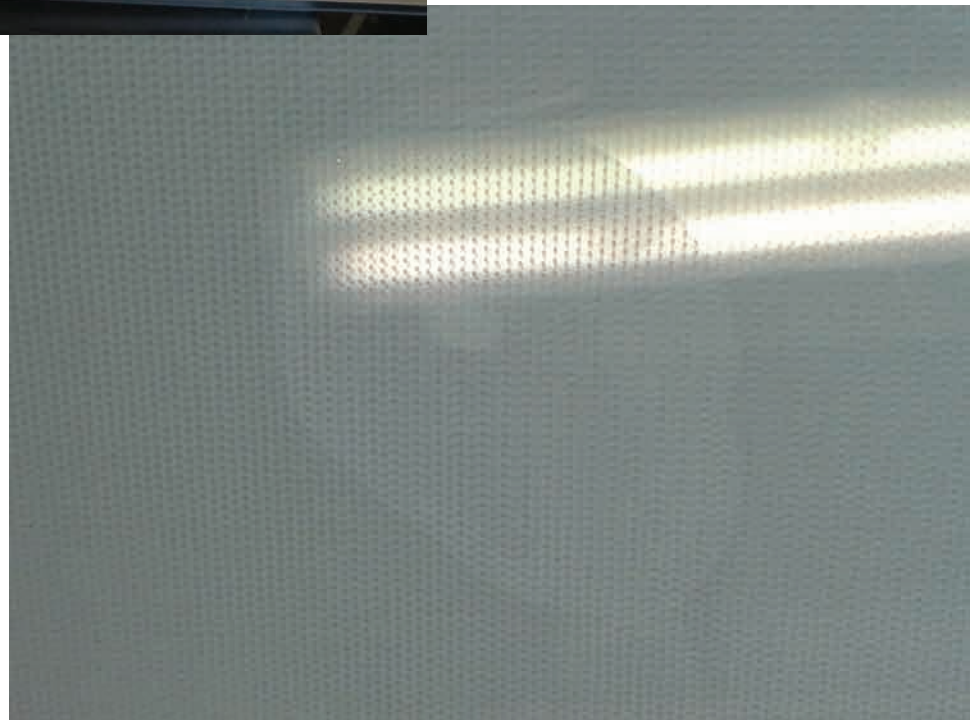
8. Vochtplekken tussen de verschillende platen in de panelen.
